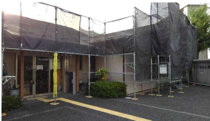
足場を組み 8月28日
